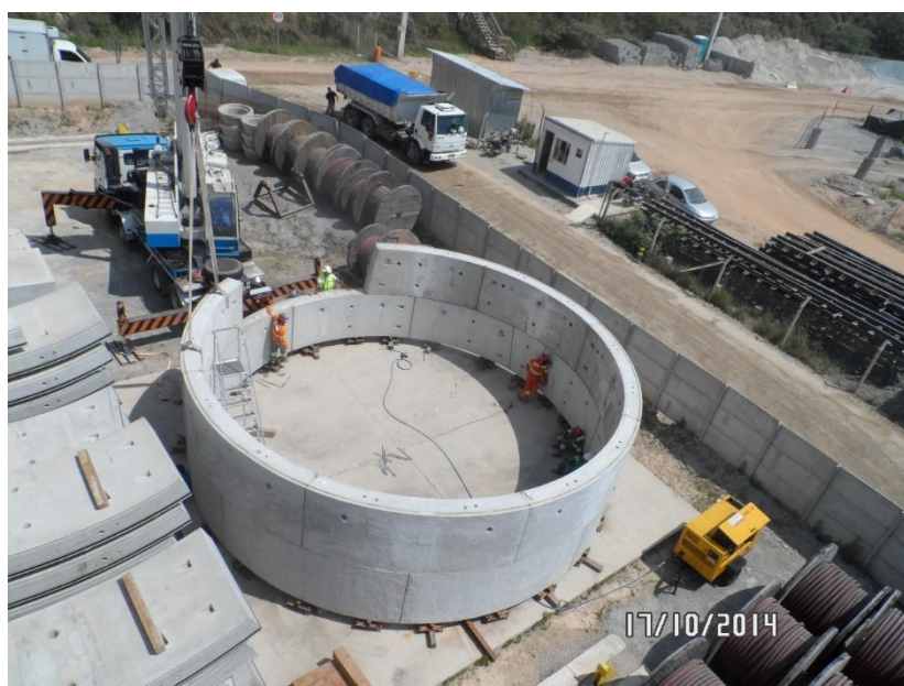
Figura 03. Montagem de anéis pré-montados do túnel singelo
