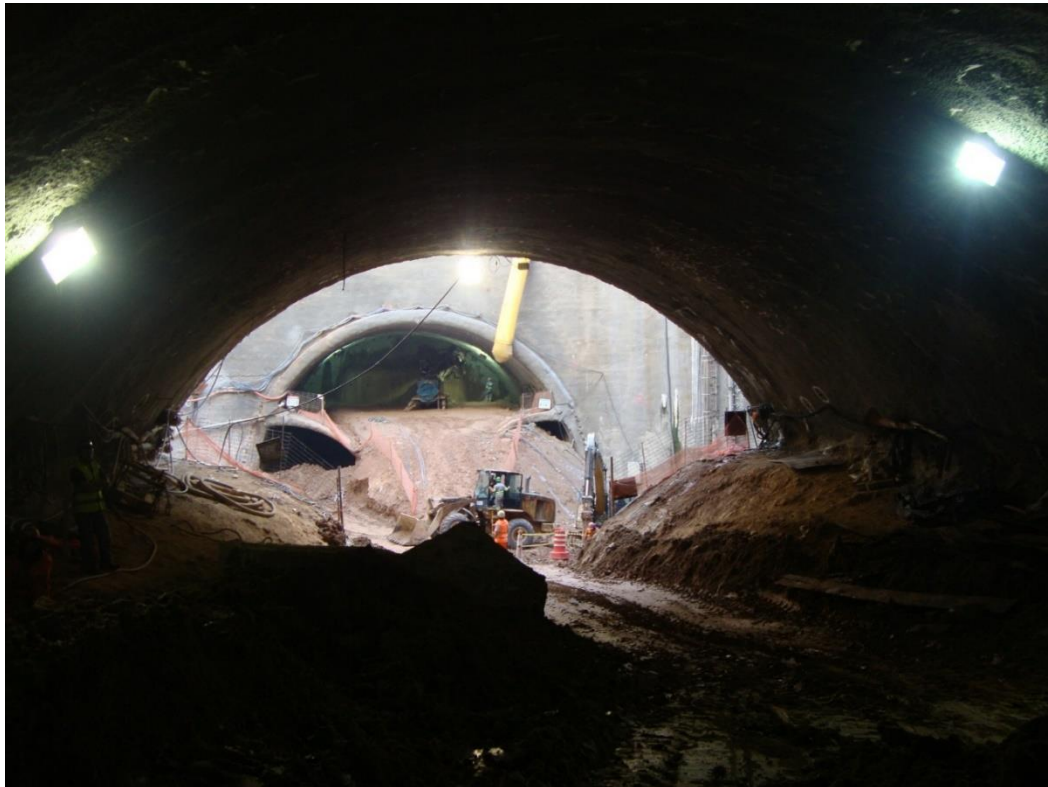
Figura 01. Escavação do túnel duplo em NATM
